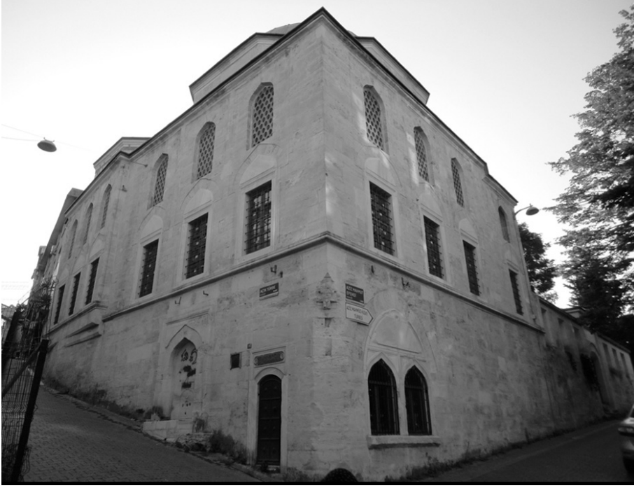
Halil Paşa Türbesi, Sebili ve Çeşmesi
